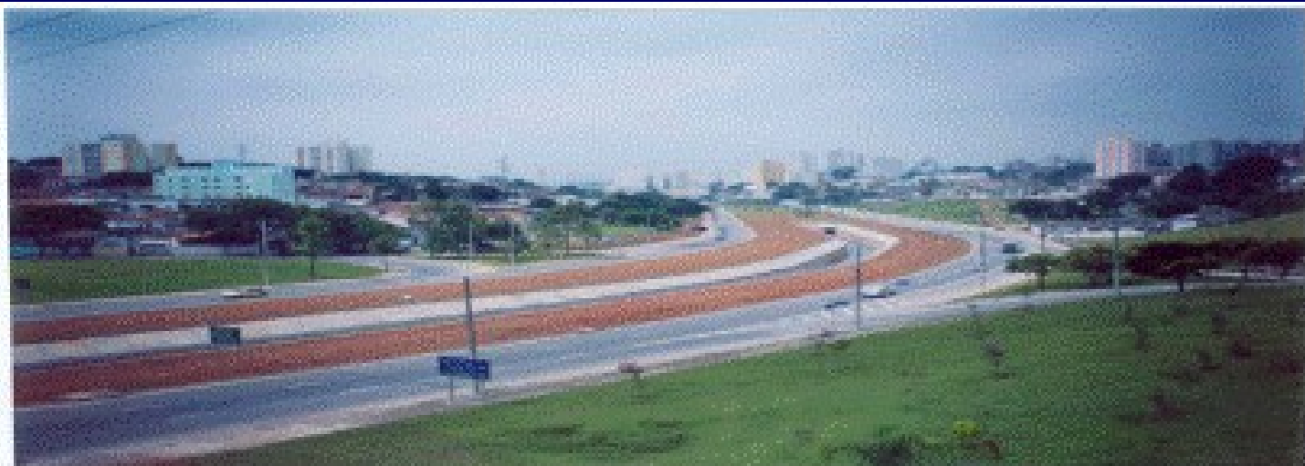
F01 – Foto feita sobre o Viaduto Raquel Marcondes, com vista para o local onde será construída uma das passarelas para pedestres.
