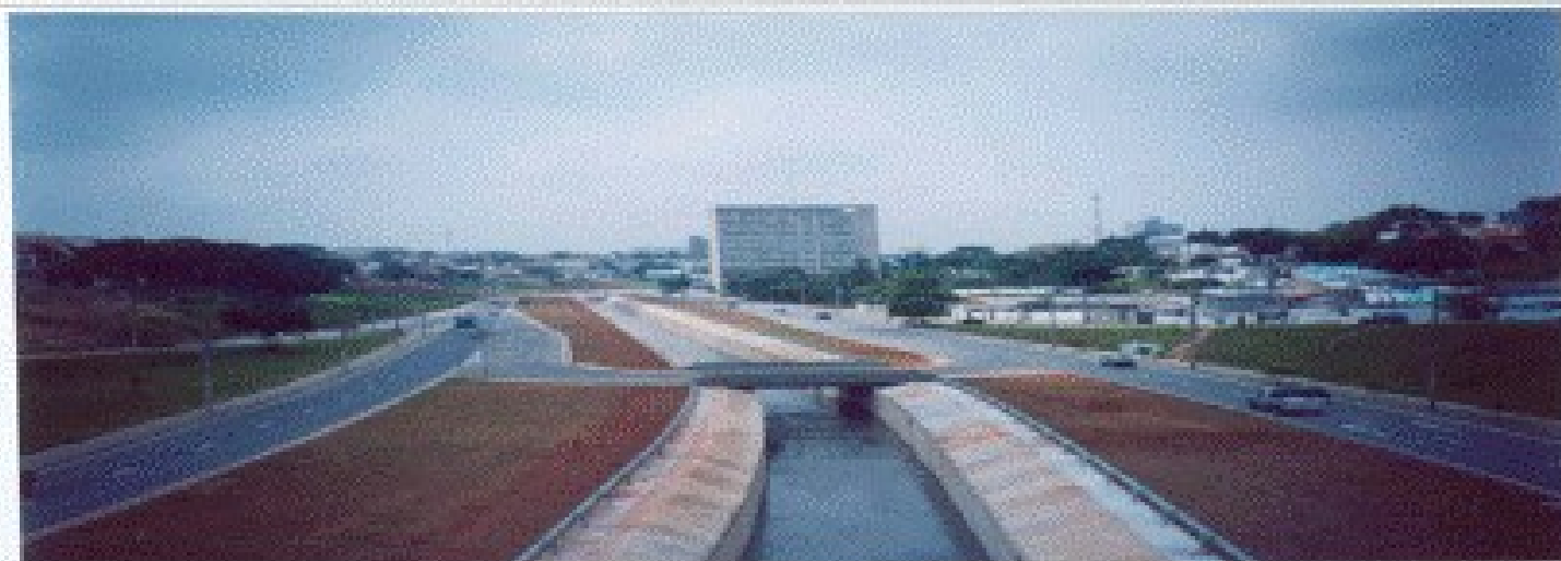
F02 – Foto feita sobre o Viaduto Professor Everardo Passos, com vista para o local onde foi construída a ponte rodoviária e mais ao fundo, junto ao Paço Municipal, o local para a construção da outra passarela para pedestres.
